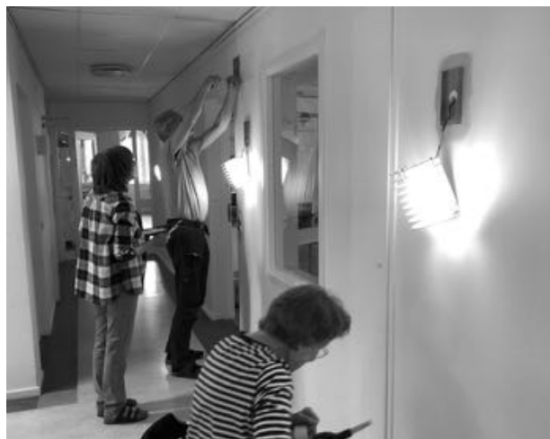
Förberedelser för målning av väggen mot syrummet/tvättstugan.
